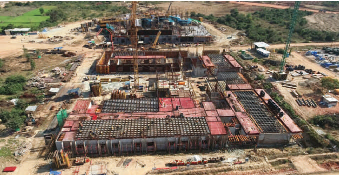
▲ विभाग ब्लॉक-1 निर्माण
