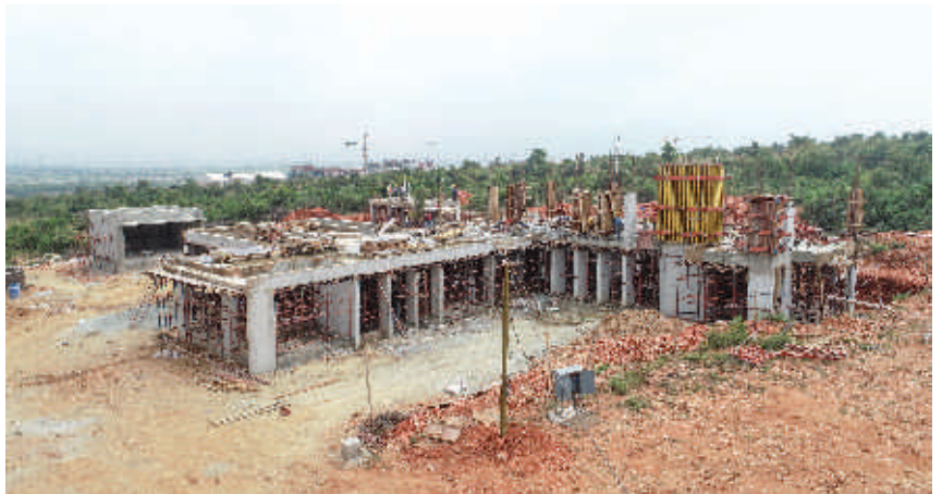
साइट पर निदेशक के ▶▶ आवास का निर्माण
